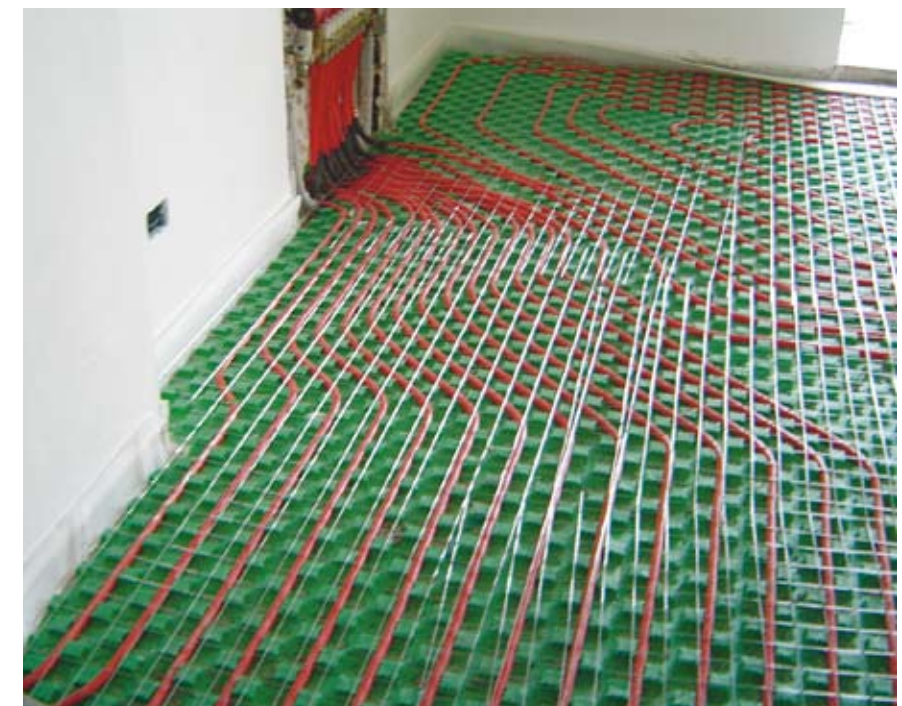
pannelli radianti a pavimento posati nel cantiere Habitarea di Alessandria
